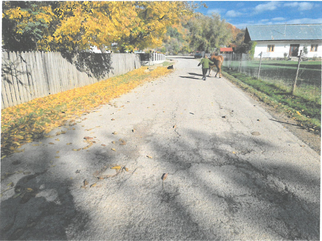
Gropi cu fisuri longitudinale
