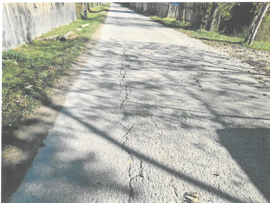
Fisuri longitudinale
