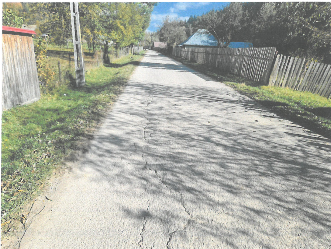
Fisuri longitudinale
