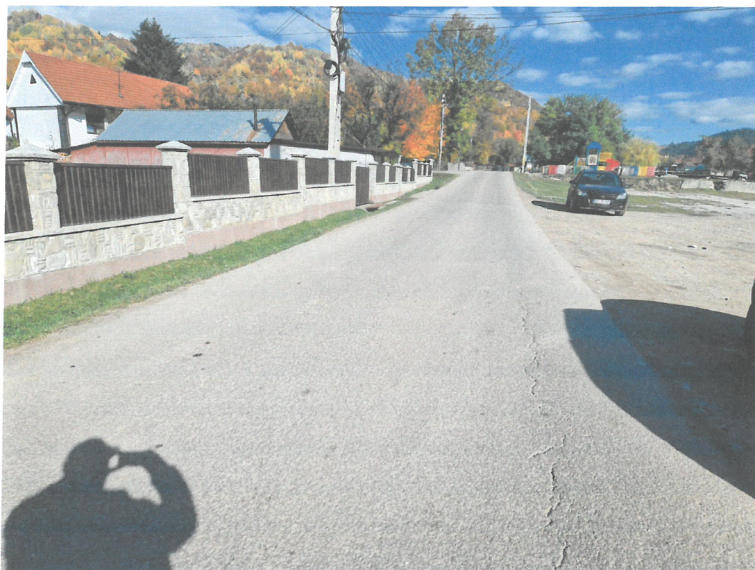
Fisuri longitudinale
