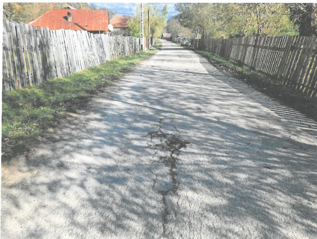
Fisuri longitudinale
